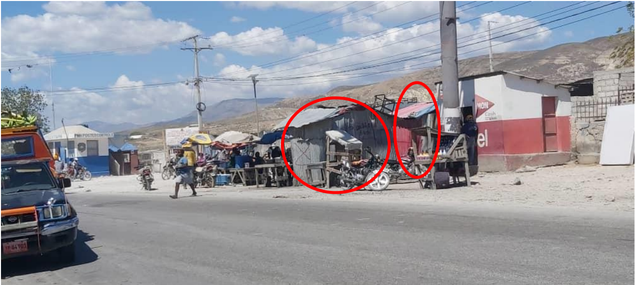
Une vue des deux kiosques de vente à déplacer pour les besoins des travaux
