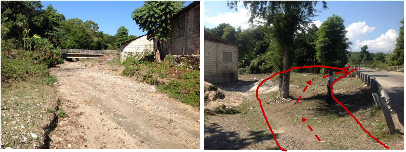
Figure 3. Photo de l'emprise des travaux au niveau de la Ravine Sèche (gauche) et de l'emprise de la déviation temporaire et de la voie d'accès sud des engins (droite) / Pont Bellevue
