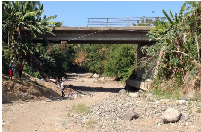
Figure 4. Vue de l'emprise des travaux au niveau de Pont Cutis
