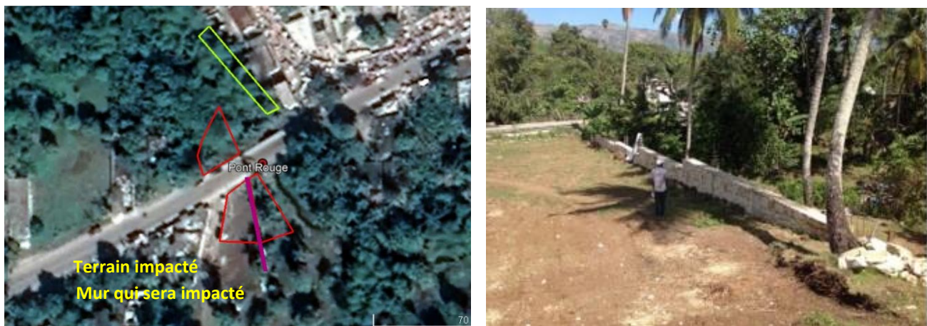
Figure 3. Vue aérienne des sites d'impacts (en rouge) et vue du mur impacté (en mauve) (pont Rouge)
