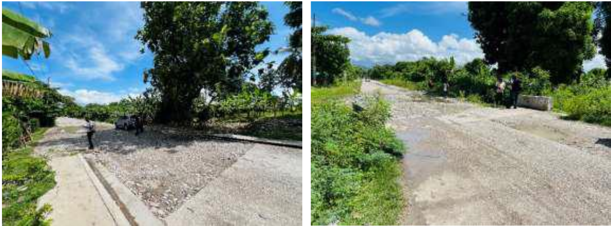
Figure 2. Sites de construction de dalot dans la ville de Chantal
