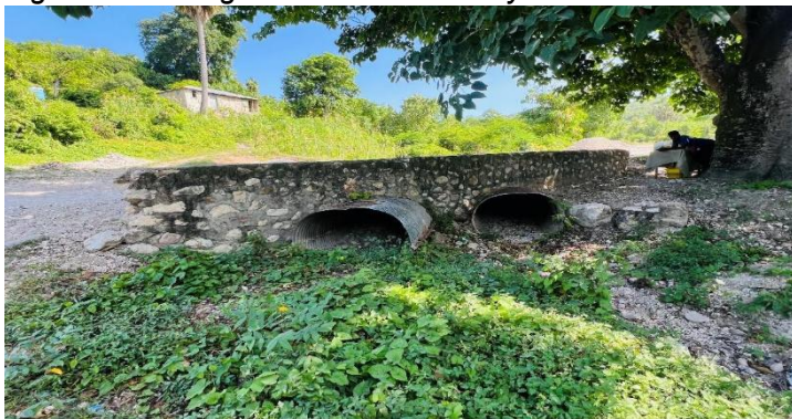
Figure 1. Ouvrage à reconstruire à Pyron
